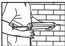
Le pistolet à mortier SpiroFix fonctionne comme un pistolet à silicium, appliquez une pression constante sur la gâchette. Le mécanisme est puissant et ne demande pas beaucoup de force. Si le pistolet se coince, ne forcez pas. Tirez la poignée en T vers l'arrière et videz le conteneur de mortier.
