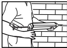
Het SpiroFix Mortelpistool werkt als een siliconenpistool, oefen een constante druk uit op de trekker. Het mechanisme is krachtig en vereist niet veel kracht.
